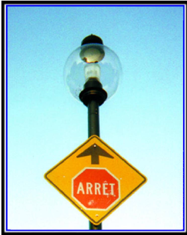
*Exemple de luminaire à proscrire, car il laisse échapper la lumière vers le haut.*
